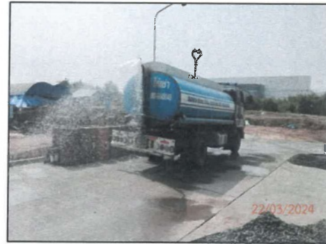
รูปที่ 2-5 การฉีดพรมน้ำป้องกันฝุ่นละออง
