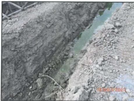
รูปที่ 2-16 รางระบายน้ำและบ่อดักตะกอนดิน
