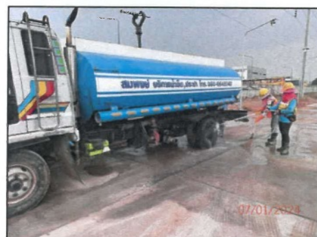
รูปที่ 2-7 บ่อล้างล้อและการทำความสะอาดล้อรถบรรทุกก่อนออกจากพื้นที่โครงการ
