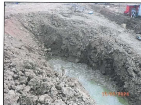
รูปที่ 2-16 รางระบายน้ำและบ่อดักตะกอนดิน
